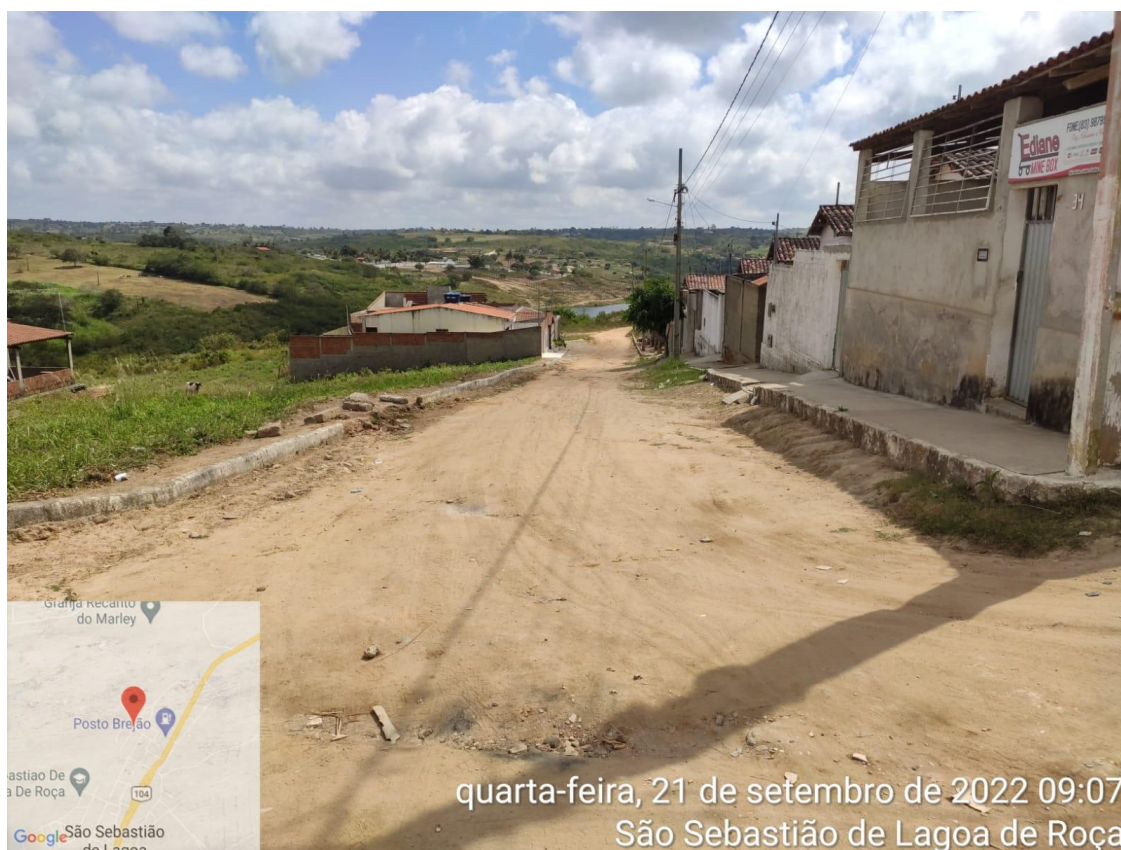
IMAGEM 7: RUA PROJETADA 12 - TRECHO 02
