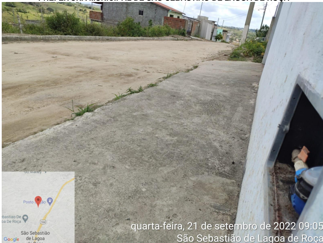
IMAGEM 6: RUA PROJETADA 12 - TRECHO 01
