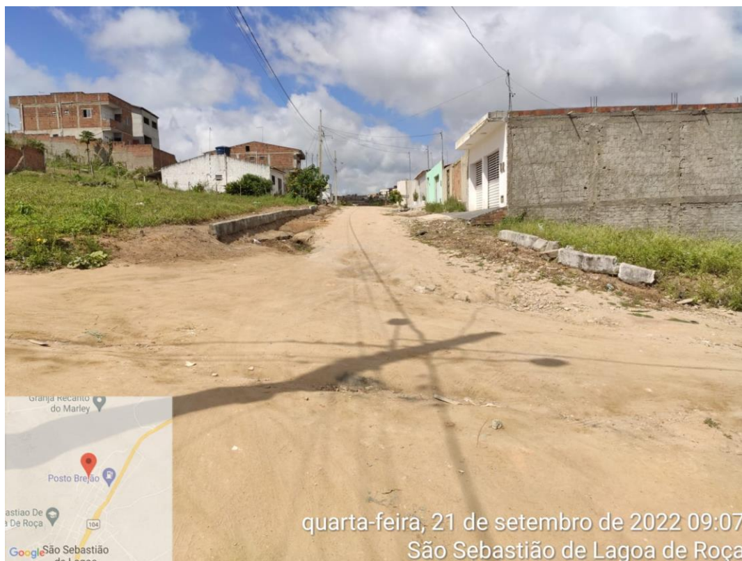
IMAGEM 4: RUA PROJETADA 12 - TRECHO 01
