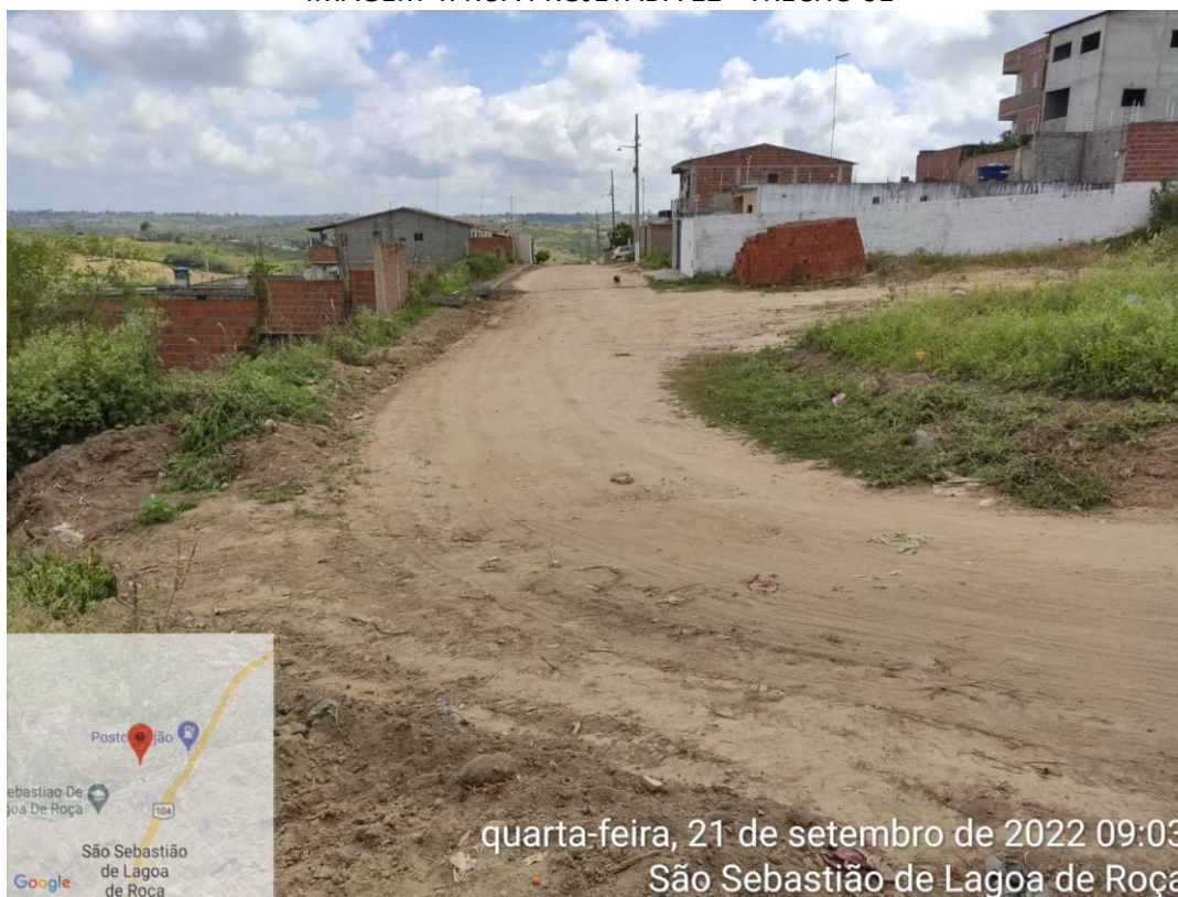
IMAGEM 5: RUA PROJETADA 12 - TRECHO 01
